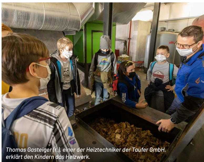
Schüler beim Besuch des Heizwerkes der Taufer GmbH
